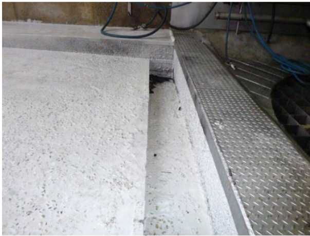
Fotonummer: 9 Omschrijving: Aanwezige open constructieve goten.
