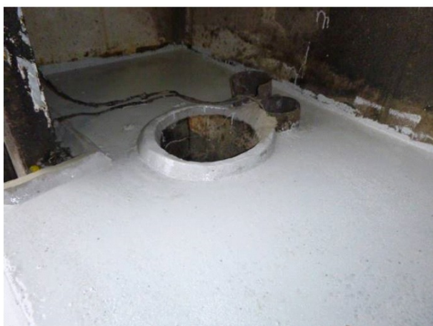
Fotonummer: 5 Omschrijving: Detail doorvoeren.
