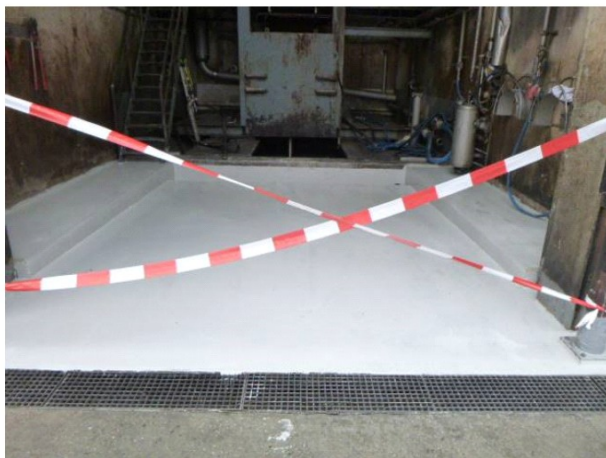
Fotonummer: 1 Omschrijving: Overzicht vloer voor de stortputten.
