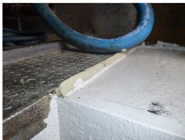
Fotonummer: 6 Omschrijving: Detail vloeistofdichting t.p.v. rand voorziening opstort.
