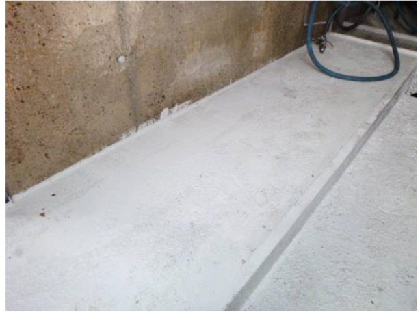
Fotonummer: 8 Omschrijving: Detail aansluiting opstort/muur.
