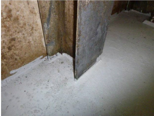
Fotonummer: 7 Omschrijving: Detail aansluiting bouwkundige delen.
