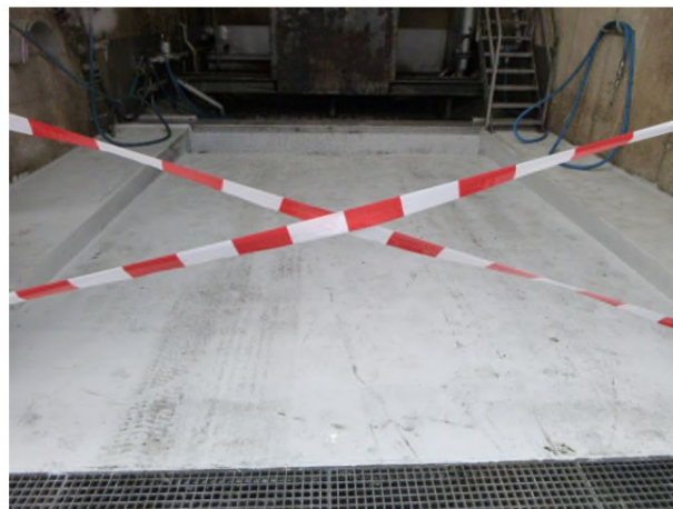
Fotonummer: 2 Omschrijving: Overzicht vloer voor de stortputten.
