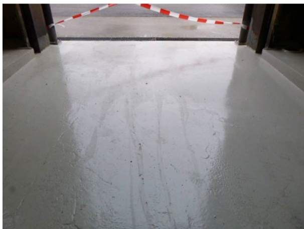
Fotonummer: 3 Omschrijving: Overzicht vloer voor de stortputten.
