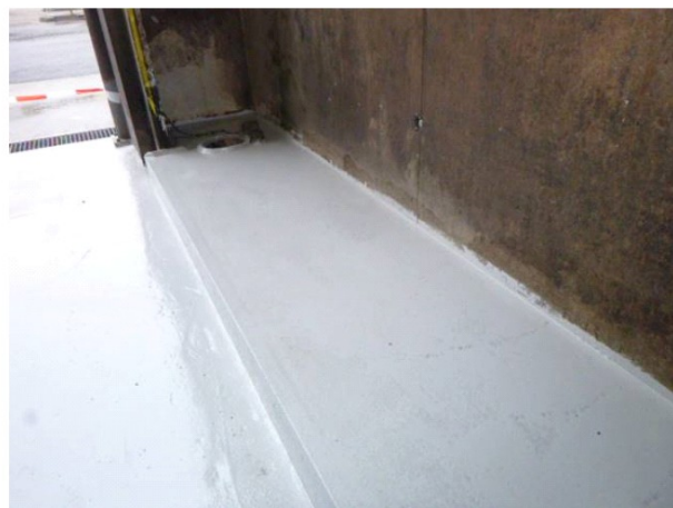
Fotonummer: 4 Omschrijving: Overzicht vloer voor de stortputten.
